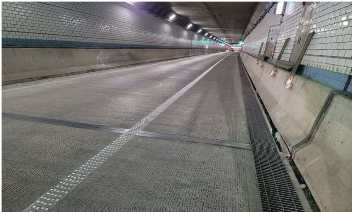
BOX구간 포장 전경
