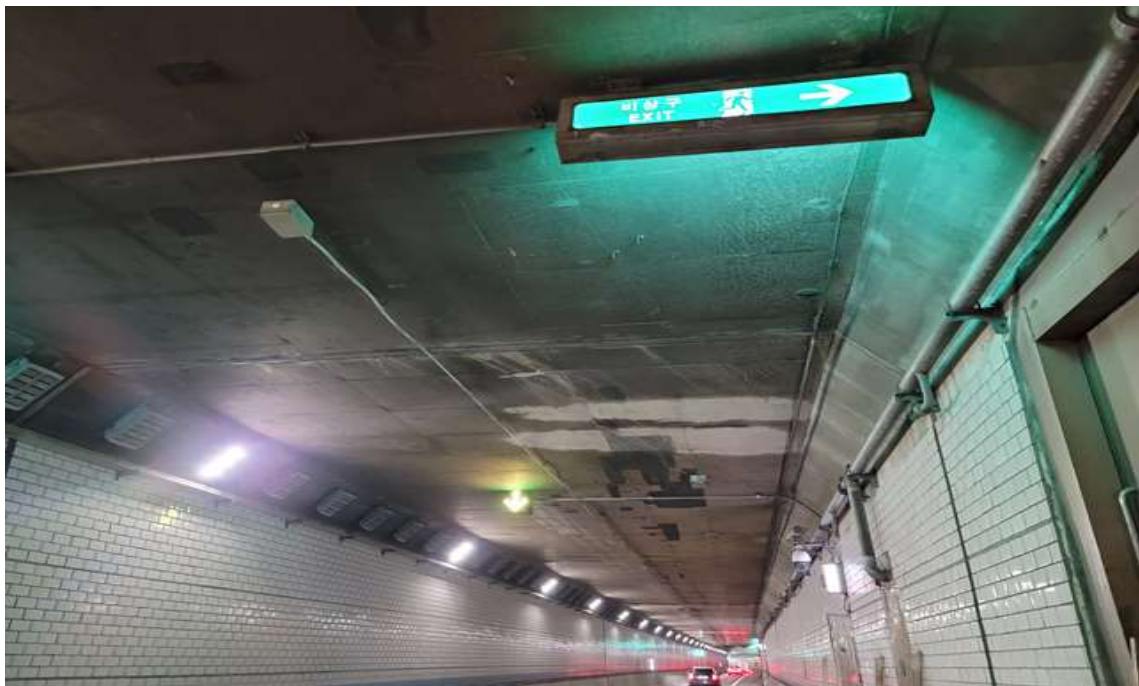
BOX구간 슬래브 전경
