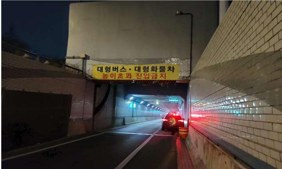
RAMP-D 갭문 전경
