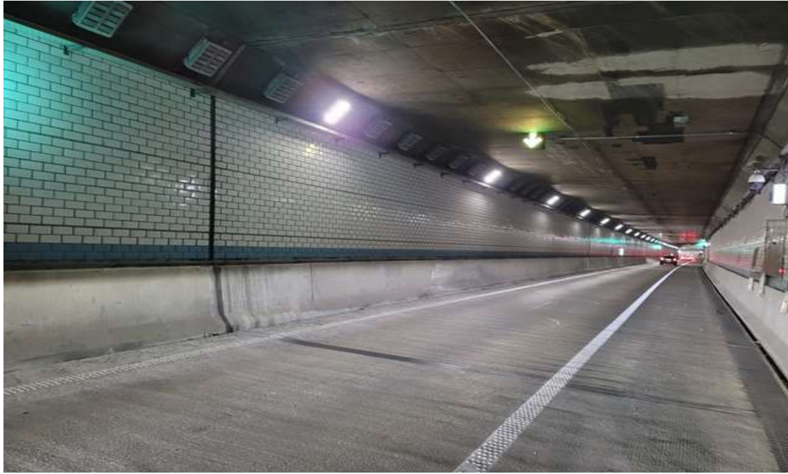
BOX구간 벽체 전경
