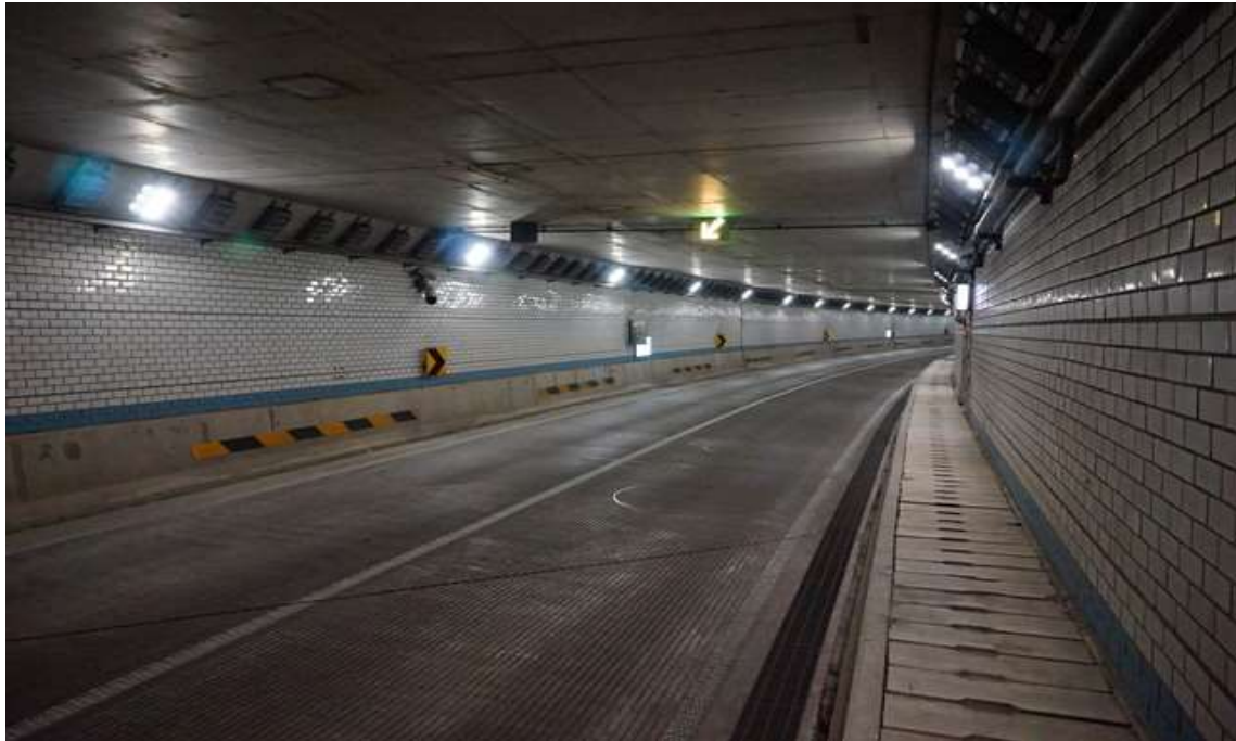
BOX구간 내부 전경
