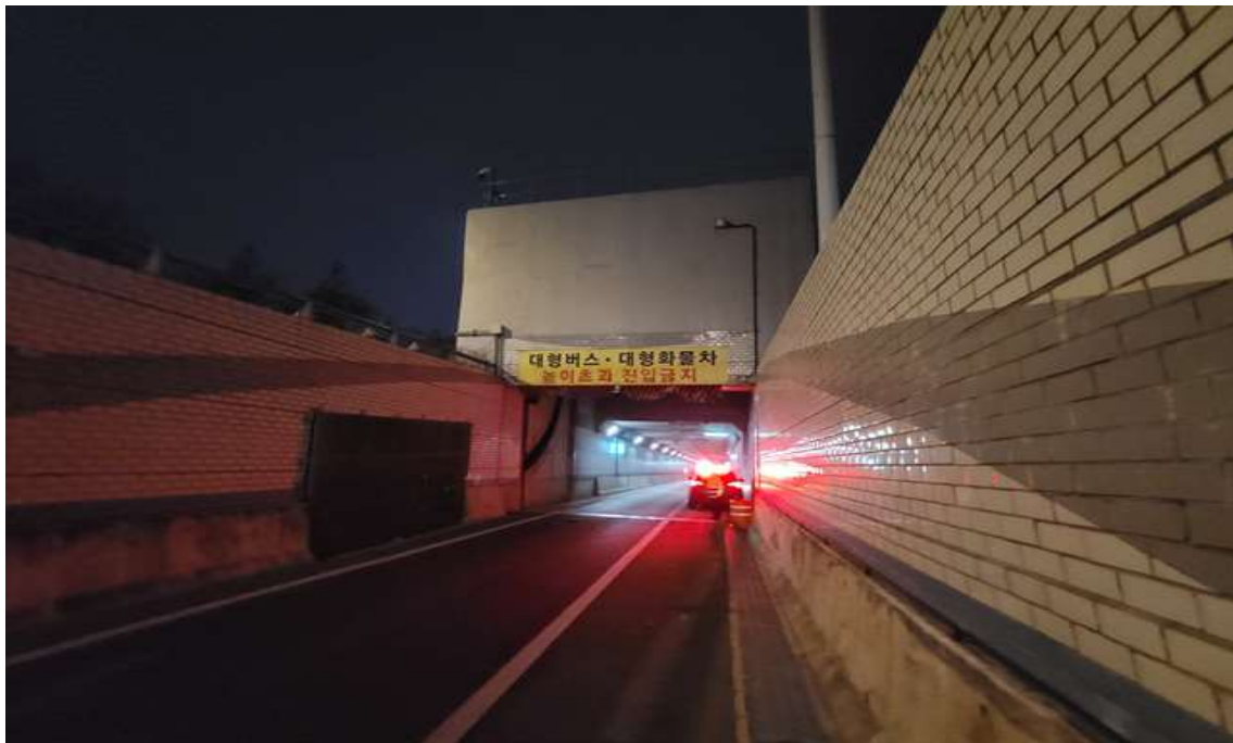
Ramp-D 갭문 진입부 전경
