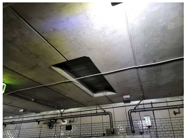
풍도슬래브 하면 S51 상태양호
