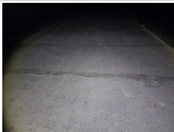
풍도슬래브 상면 S50 상태양호
