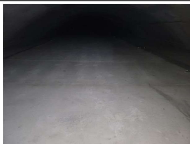
풍도슬래브 상면 S48 상태양호
